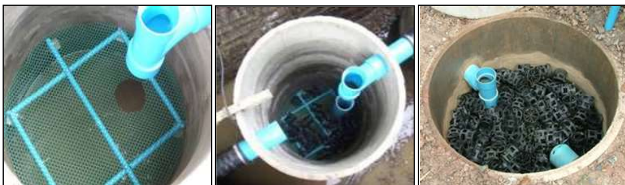
รูปที่ 4 - 4 การติดตั้งชั้นตัวกลางภายในบ่อกรองไร้อากาศ
